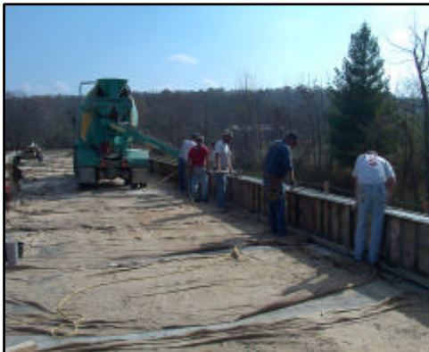
Pouring the railing
